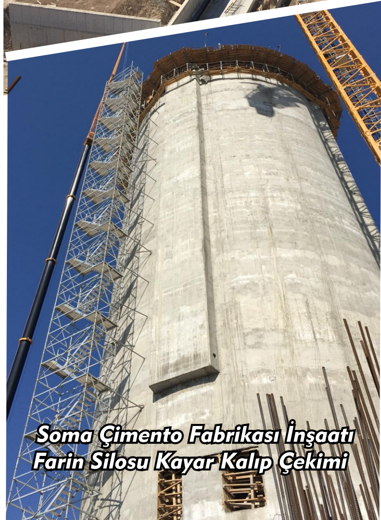
Soma Çimento Fabrikası İnşaatı Farin Silosu Kayar Kalıp Çekimi
